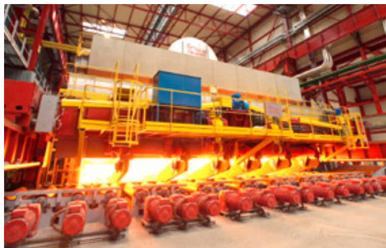
Einsatz von Armaturen im Stahlwerk, Beispiel: Hubballknofen von Fives Stein
