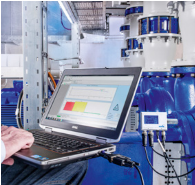
Durchführung eines „Pump Operation Check“ an einer einstufigen Wasserpumpe der Baureihe Etanorm. Bild: © KSB Aktiengesellschaft, Frankenthal
