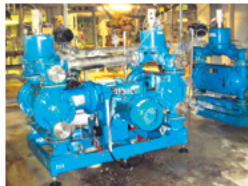
Abb. 2 EM-Pumpe im Einsatz
